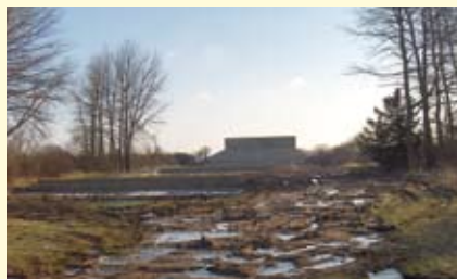
Kuglefang bane Nord – 8 meter høj betonmur beklædt med 4 tommer lægter.
